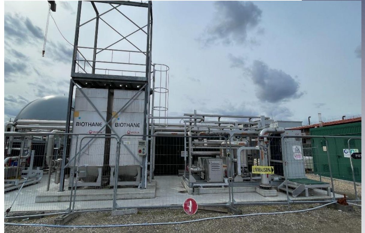
Dopływ biogazu / Wymiennik / Filtry węglowe
